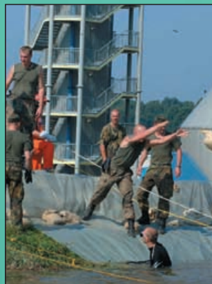
Viele Tausend Quadratmeter Folie werden von DLRG-Tauchern verlegt.
