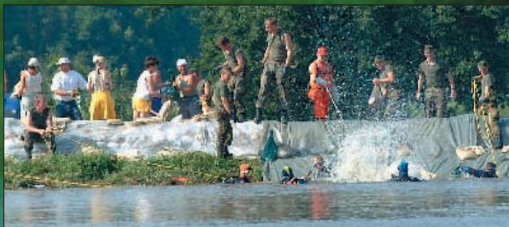
Bundeswehr und andere Helfer unterstützen die DLRG-Taucher beim Verlegen und Beschweren der Folie.
