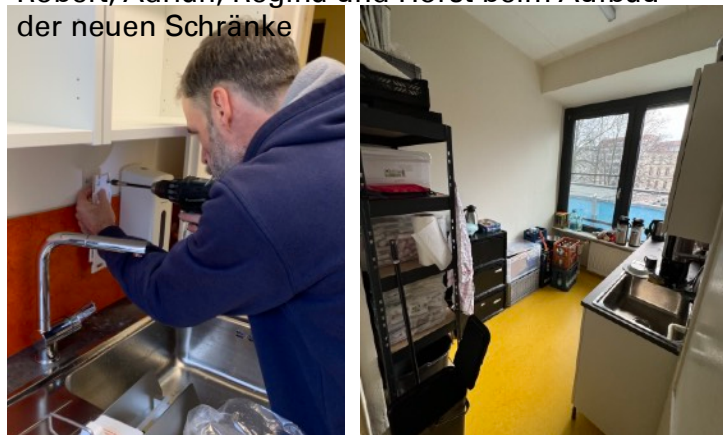
Dirk beim Einbau der Küchenzeile
