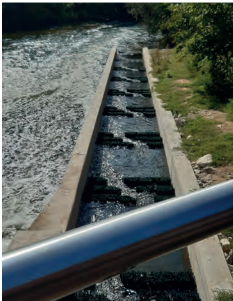
Die in den natürlichen Flusslauf eingebaute Borsten-Fischtreppe, die auch als Bootsruhsche genutzt werden kann, wenn die Pegnitz bei Betrieb der Wellenanlage aufgestaut wird.
