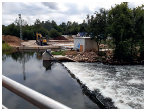
Am 4. August war die Baustelle noch voll im Gange. Im Vordergrund das Wehr, mit dem der natürliche Flusslauf der Pegnitz aufgestaut und das Wasser in den künstlich geschaffenen Seitenkanal umgelenkt wird.
