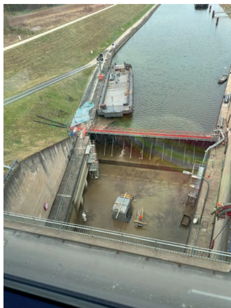
Blick von oben: Die Schleusenzufahrt und das untere Schleusentor aus der Vogelperspektive.
