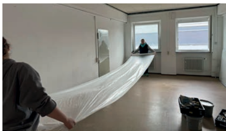
Der Sitzungsraum soll zum Jugendraum werden: Alle Einrichtungsgegenstände wurden entfernt, ebenso die Holzdecke. Jetzt kann die eigentliche Renovierung beginnen.
