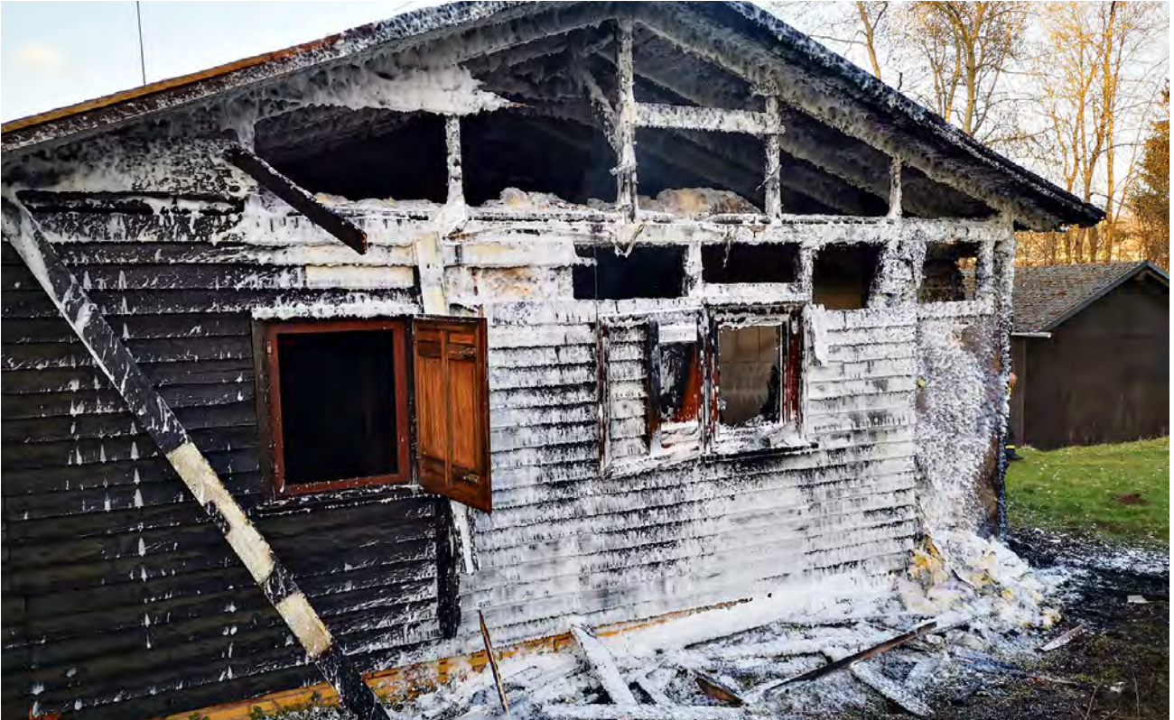
Das Feuer zerstörte die alte Wasserrettungsstation komplett.
