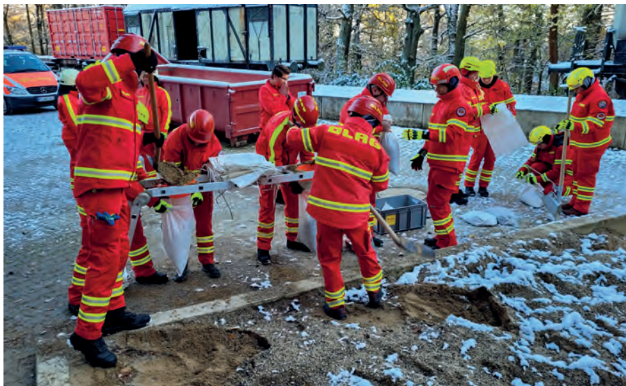
Der Bau eines Sandsackverbau zum Hochwasserschutz und der praktische Umgang mit Tauchpumpen waren Teil der Übung.
